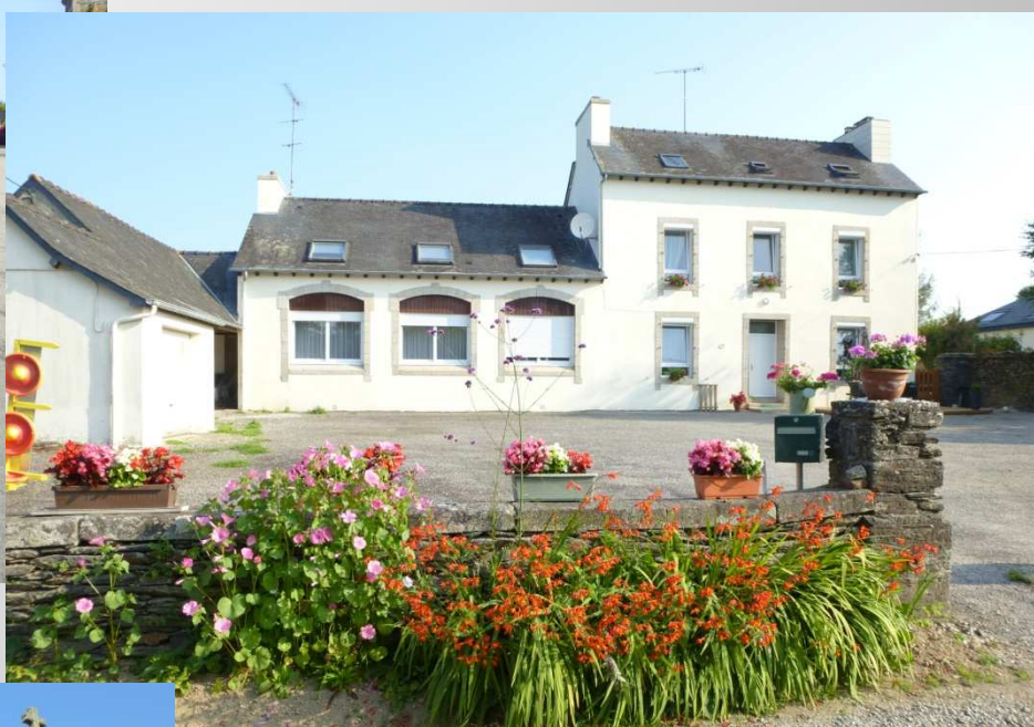
Ravalement des logements de l'école
