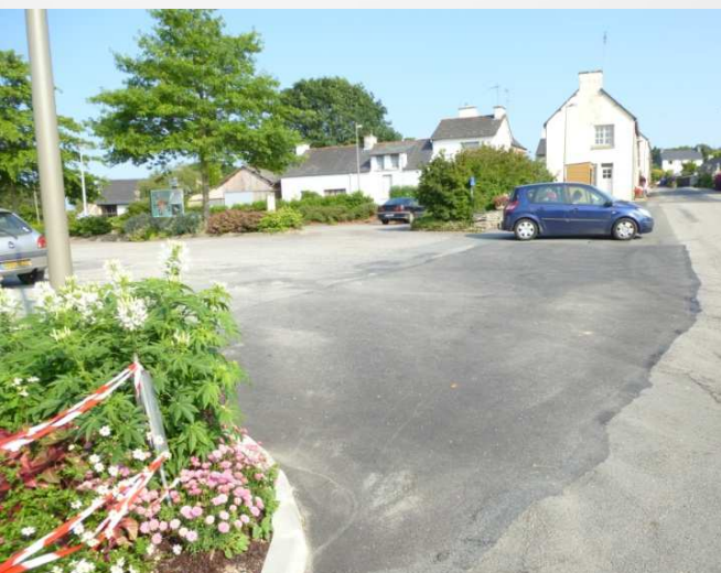
Réfection du réseau d'eau pluviale
