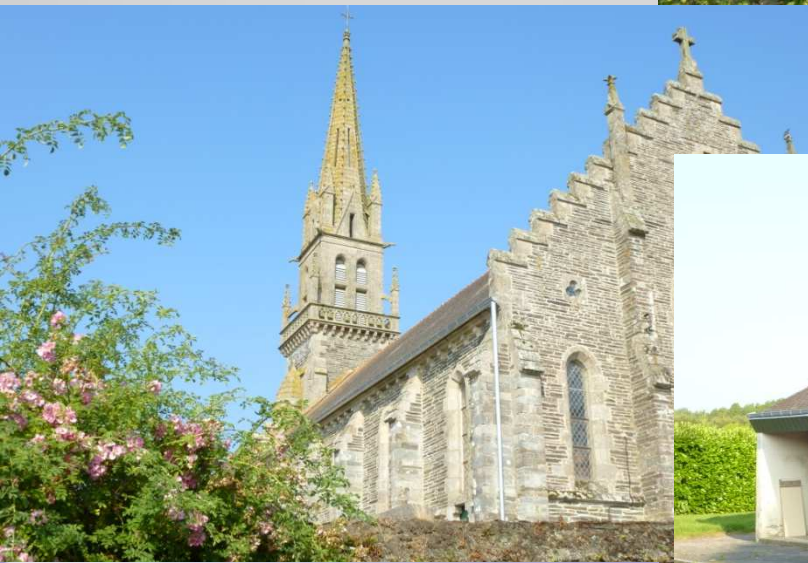
Réfection de la toiture et des gouttières
